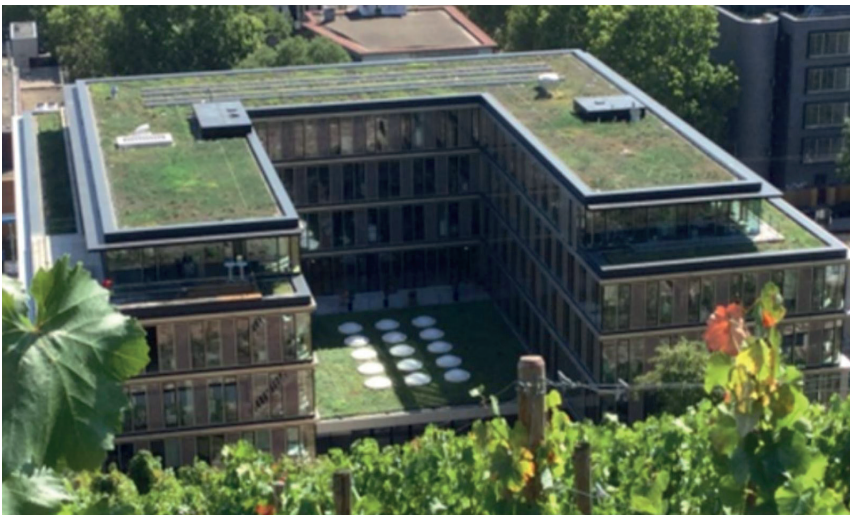
Photovoltaik-Dachanlage und ökologische Dachbepflanzung (Foto: IHK Region Stuttgart)
