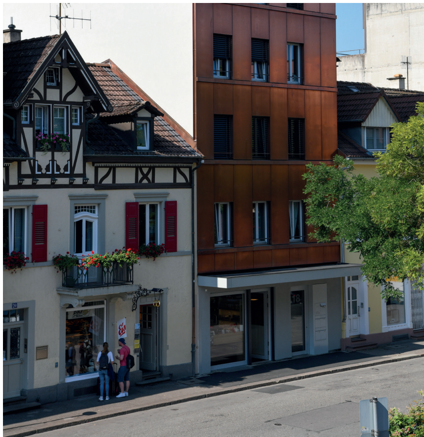
Energieeffiziente Nachbarschaft: der sanierte Altbau (l.) und der im KfW-55-Standard errichtete Neubau der Bäckerei Paul. (Foto: Juri Junkov)
