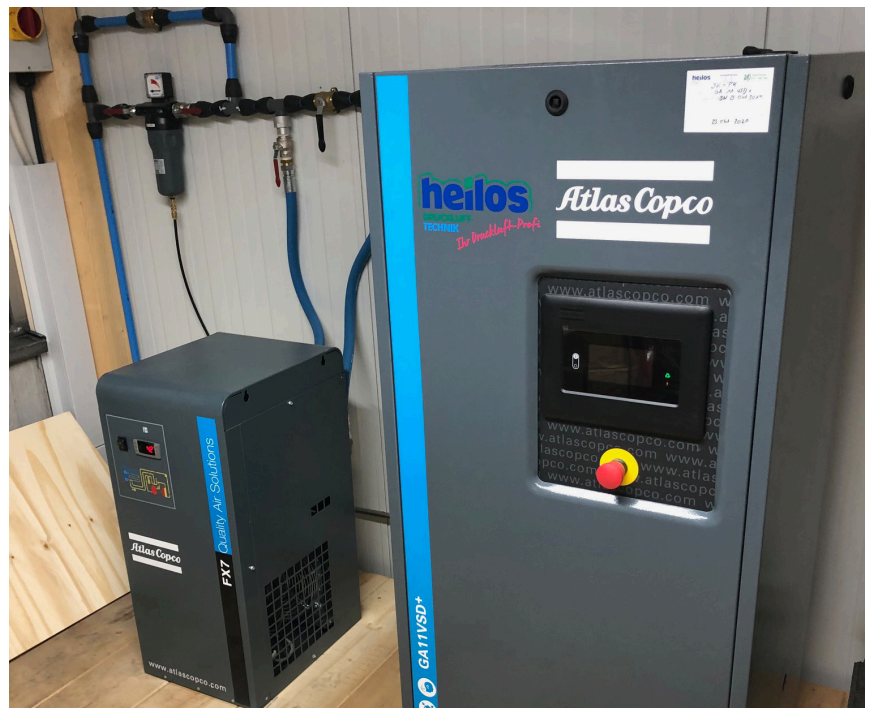
Die Druckluftanlage und die -leitungen wurden erneuert. (Foto: Ballweg + Büttner GmbH)
