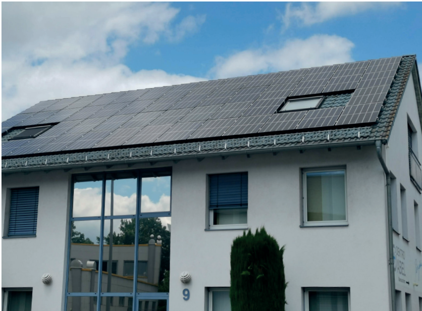
Auf dem Firmengebäude wurde eine Photovoltaikanlage installiert, die das Verwaltungsgebäude und die drei Elektrotankstellen versorgt. (Foto: Dektro Abel GmbH)
