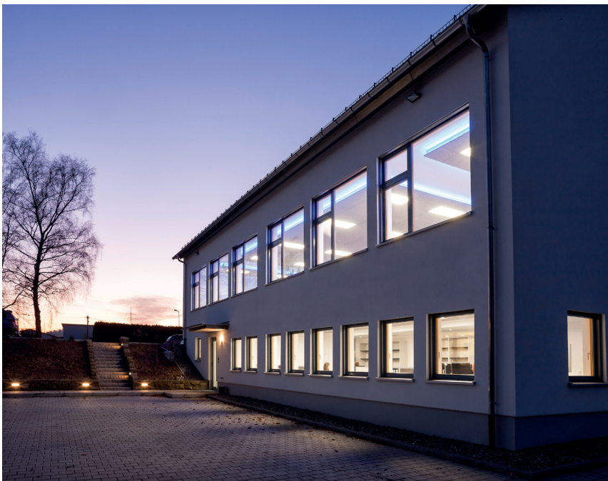
Nach einer Komplettsanierung wurde aus dem alten Schulgebäude das Werk II der Fiehn Gebäudeautomation GmbH. (Foto: Fiehn Gebäudeautomation GmbH)
