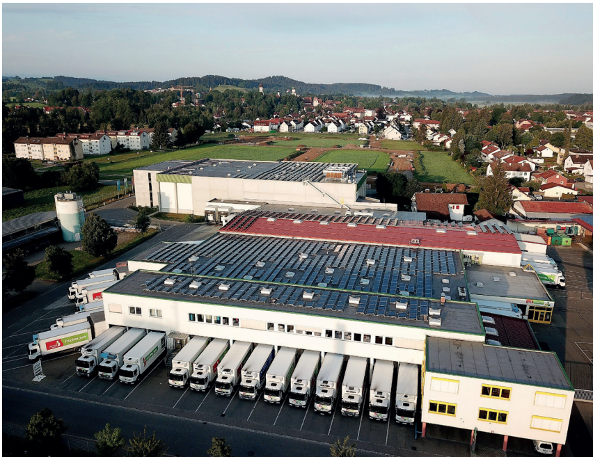
Das BHKW wird zur Wärme- und Kälteerzeugung sowie für das Nahwärmenetz genutzt. (Foto: Früchte Jork GmbH)
