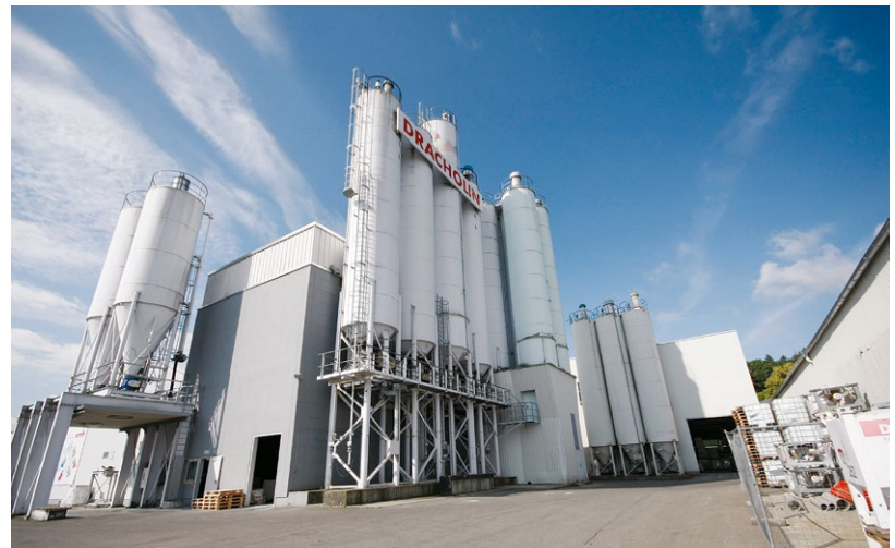
Das Betriebsgelände mit den imposanten Silos
