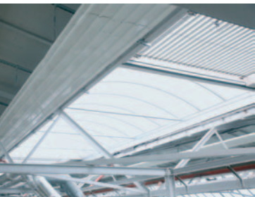
Strahlungswärme durch Deckenstrahlplatte
