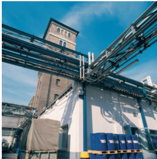
Werksgelände mit Rohrbrücken und dem Wasserturm (Baujahr 1906), © VCI
