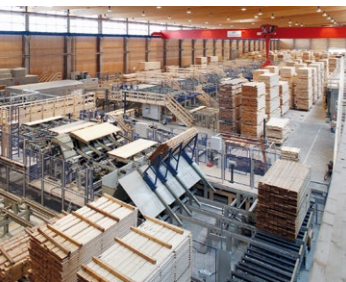
Mit Abwärme auf 26 °C beheizte Produktionshalle zur Holzveredelung
