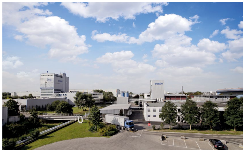
Blick auf das Werksgelände der Uzin Utz AG am Hauptsitz in Ulm
