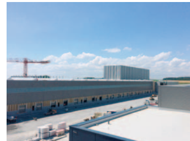
Versandzentrum im Bau
