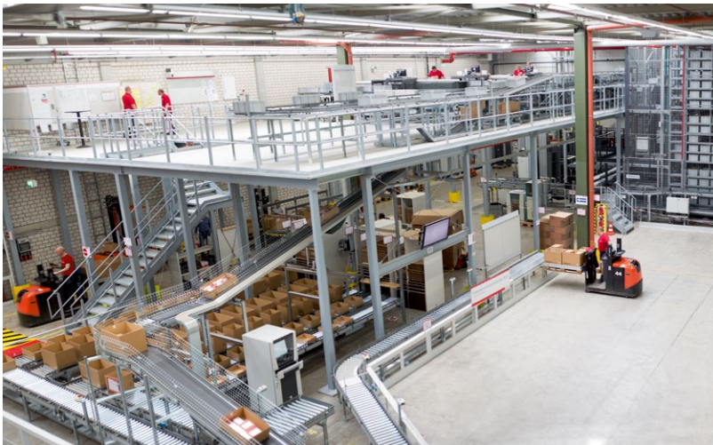
Komplettansicht Shuttle-Lager im GDC Tümlingen
