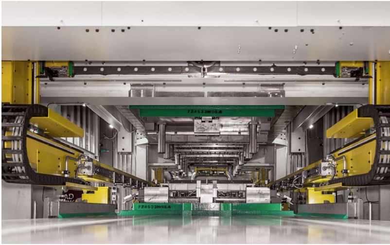
Ansicht des Pressenraums
