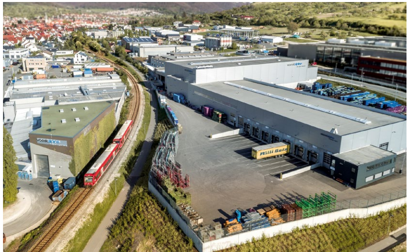
Das Werksgelände der voestalpine im schönen Ermstal
