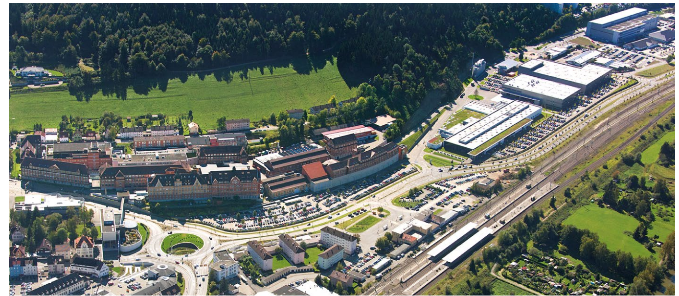
Das Betriebsgelände von Aesculap am Stammsitz in Tuttlingen
