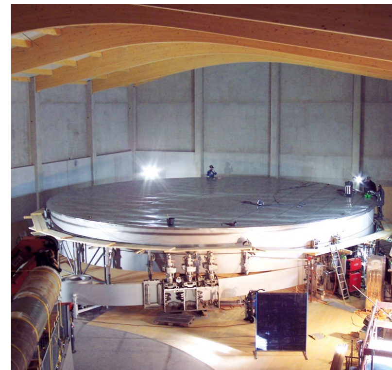
Montage des Membrandachs
