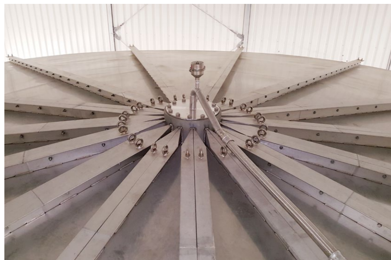
Klassisches Kegeldach mit Dachsparren
