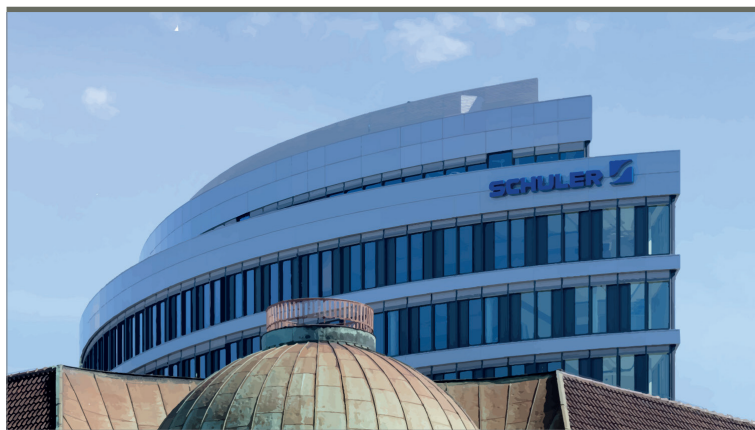
Verwaltungsgebäude Schuler AG in Göppingen; Quelle: Dirk Wilhelmy
